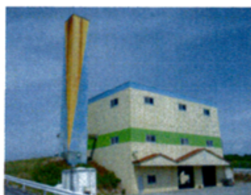
平成22年に手掛けた、多良間村ごみ処理施設基幹的整備工事
