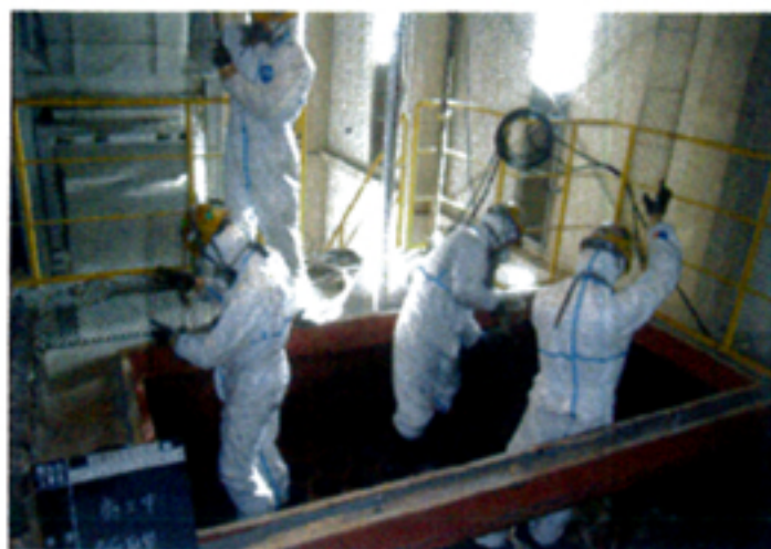
バグフィルターろ布の交換作業風景
